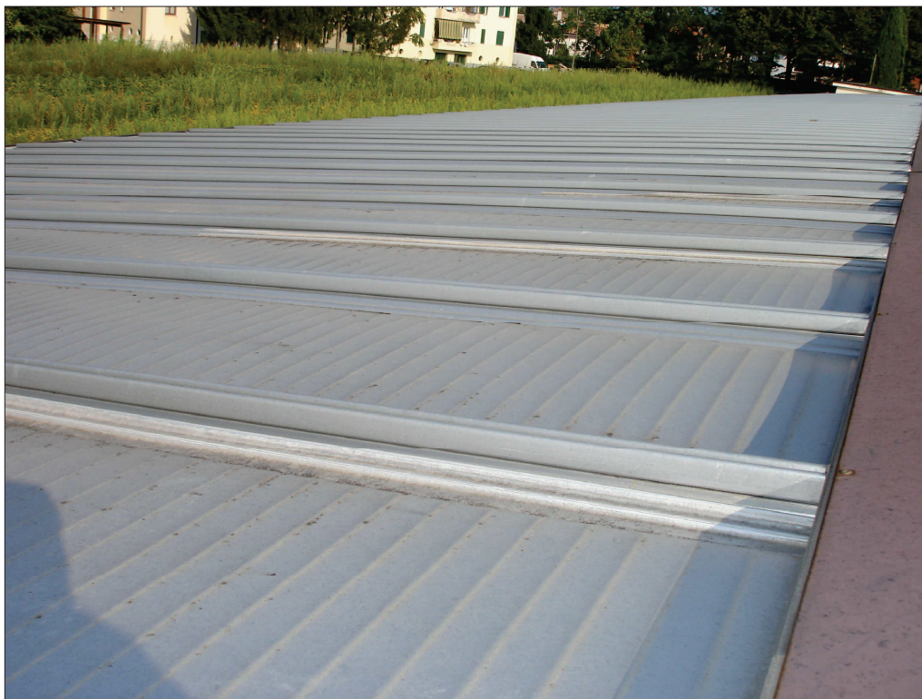
Foto 1: sito di installazione n. 12 moduli
