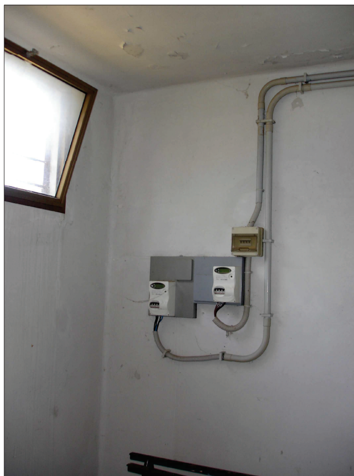
Foto 2: sito di installazione inverter e quadri elettrici
